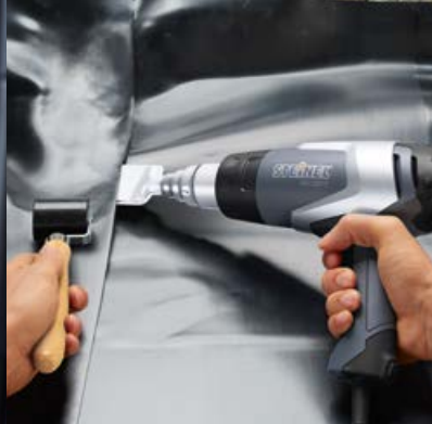
▲ Saldatura di membrane impermeabilizzanti HG 2320 E
