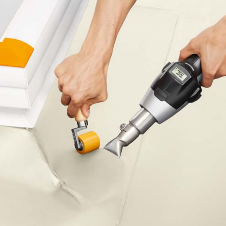
▲ Saldatura per sovrapposizione HG 2620 E
